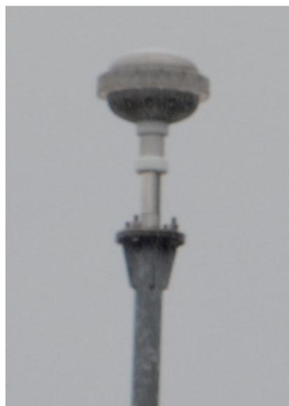
図2 絶縁電極形雷保護システムの例
