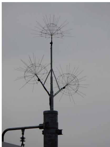
図 1 消雷システム形雷保護システムの例
